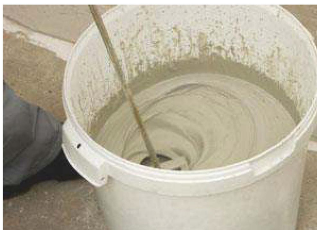
Рисунок 1 - Приготовление состава из сухой смеси и воды
