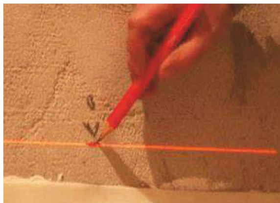
Рисунок 5 - Вынос на стену «нулевого» уровня
